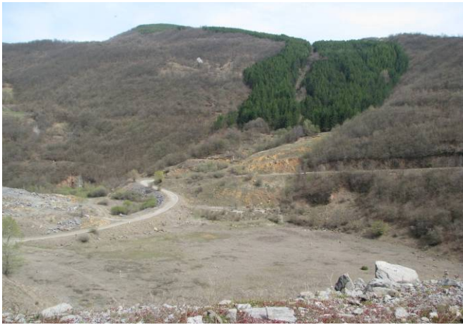
Slika 18: Klizište u neposrednoj blizini brane na Visočici (HE Pirot)
